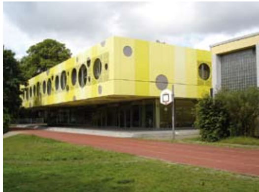
Neubau an der Lichtenrader Bruno-H.-Bürgel-Grundschule
