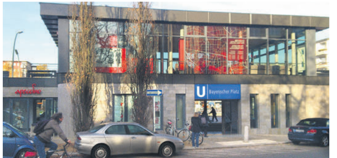
Nach Umbau wiedereröffnet: der U-Bahnhof am Bayerischen Platz
