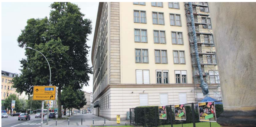
NEUER HOCHSCHUL-STANDORT | Die Umbauarbeiten für die hdpk sind in vollem Gange
