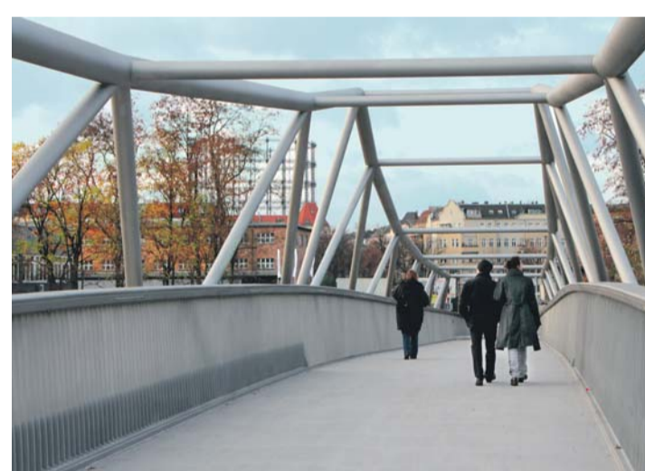
VERBINDUNG | Die neue Brücke an der Hertha-Block-Promenade FOTO: KEGEL
