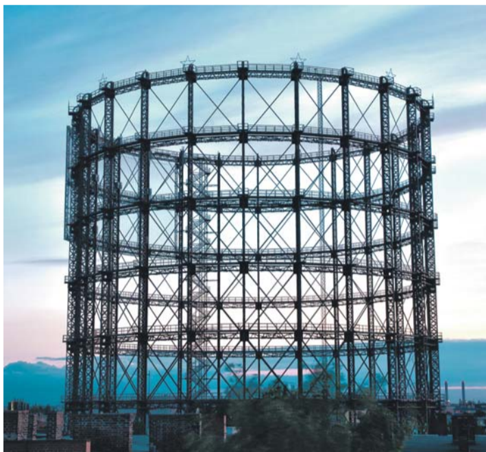
GASOMETER | Auch als Denkmal ein weithin sichtbares Symbol für den modernen Gewerbe- und Industriestandort Tempelhof-Schöneberg
